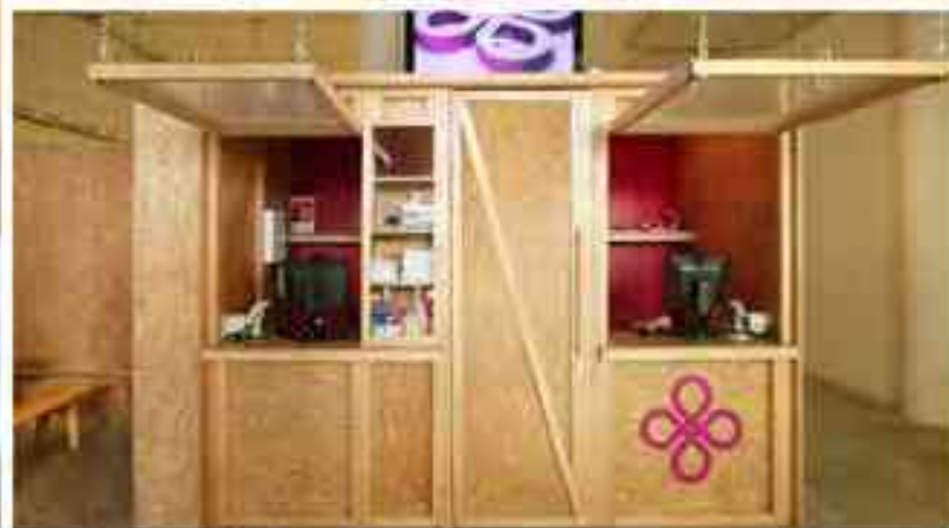
Figura 92. Elementos divisorios de contrachapado del RIA, tomado de Red de innovación y aprendizaje, (RIA, 2009)
