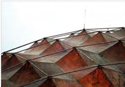
**Fig.21:** Estructura del Palacio de los Deportes. Se muestra el material y tipo de Cubierta, que envuelve al recinto, el cual en este caso se trata del uso del cobre. Fuente: *idem*. Consultada el 22 de octubre del 2016.
