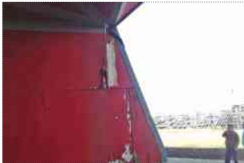
**Fig.25:** Se puede apreciar el deterioro parcial que presentan algunos de los muros del auditorio debido a la mala elección del material que cubre a todo el recinto. Fuente: *idem*. Consultada el 22 de octubre del 2016.
