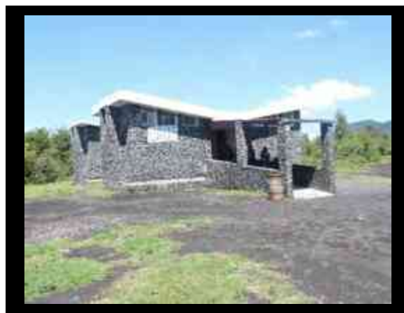
50) Sanitarios 2. Foto: J.E.M.F.
