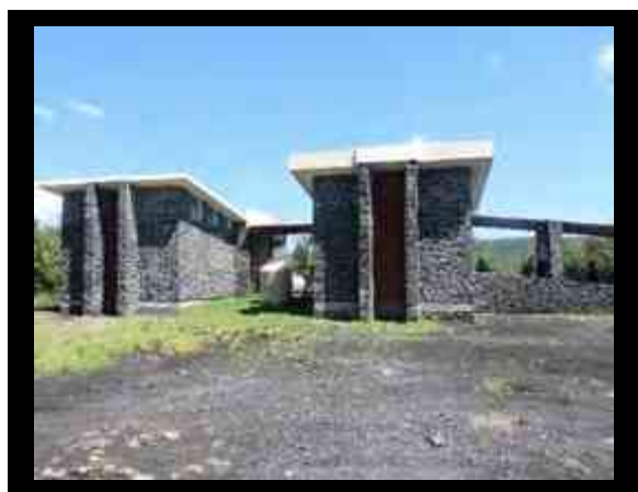
51) Sanitarios 3. Foto: J.E.M.F.
