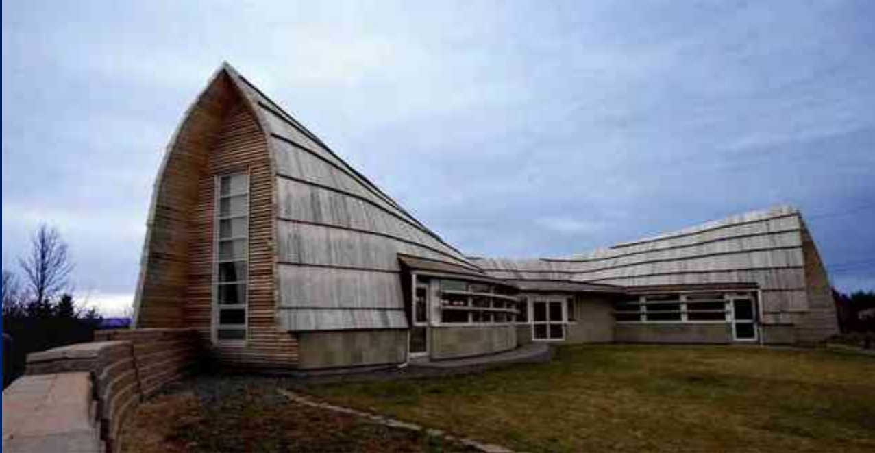
Imagen 42 Fachada principal del centro comunitario. Foto tomada por Richard Kroeker
