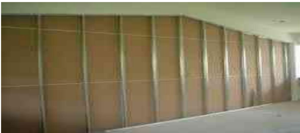
Gráfica 16. Muro de tabla-roca colocado mediante postes y canales, tomada de [www.google.com](http://www.google.com).
