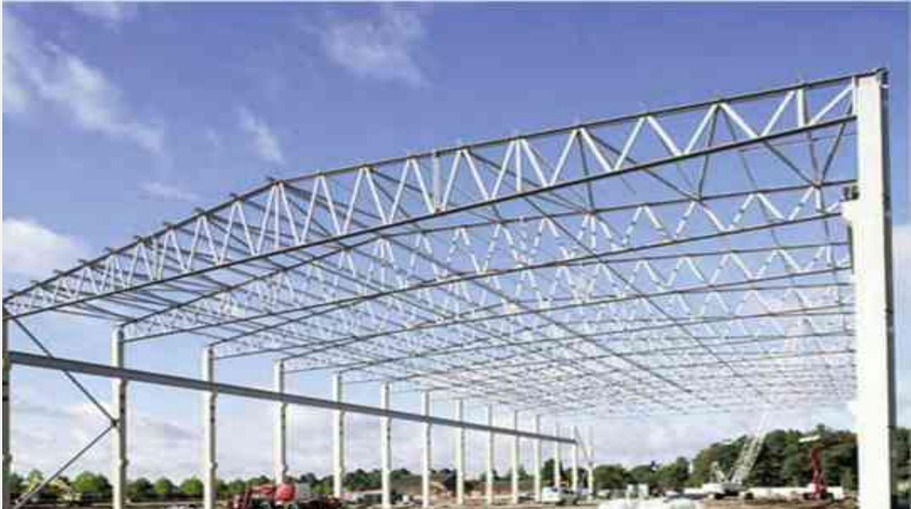
Gráfica 18. Armadura de acero en donde se ven los montantes, la armadura y las columnas sobre donde es colocada, tomada de [www.google.com](http://www.google.com)
