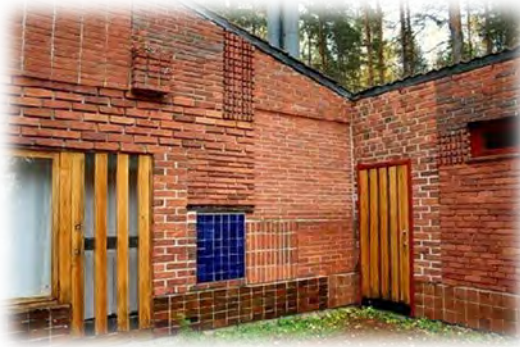
Imagen 46 Muro de tabique en su estado natural Imagen tomada http://anavedobomgosto.blogspot.mx/
