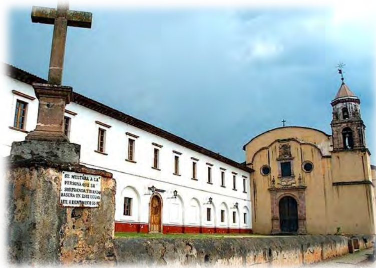
Imagen 67. Fachada de la Casa de la Cultura de Pátzcuaro
