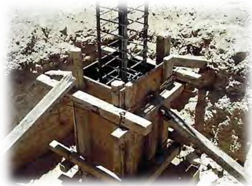
Imagen 50. Zapata aislada.
