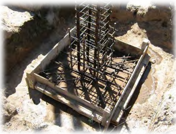
Imagen 49. Zapata aislada.
