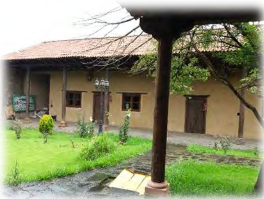
Imagen 72. pasillo de los talleres. Imagen tomada por Edgard Alejandro Vargas.
