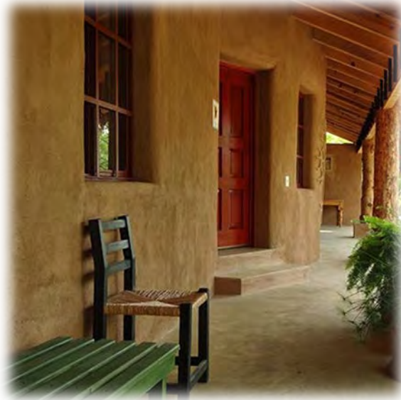
Imagen 56 Imagen de aplanado de adobe en una cabaña. Imagen tomada. www.ypasa.com.mx
