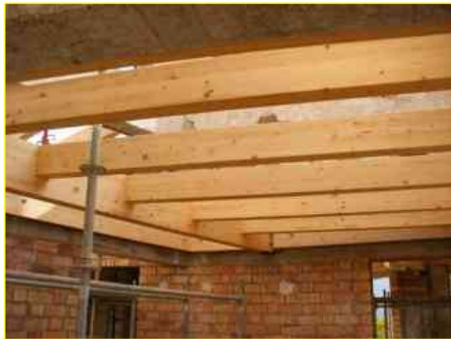
Fig.96. Viguera de madera para cubiertas a dos y tres aguas del centro cultural. Imagen. [https://www.google.com.mx/search?q=box+viguería+de+madera&rlz=1C1CHZL\\_esMX685MX685&espv=2&biw=1366&](https://www.google.com.mx/search?q=box+viguería+de+madera&rlz=1C1CHZL_esMX685MX685&espv=2&biw=1366&)
