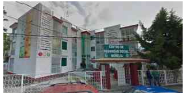
(Imagen 3) Actual estado de los talleres del IMSS, se puede observar los departamentos adaptados Imagen tomada de google maps, 17/09/2016
