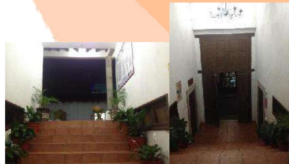
FIG. 32 ACCESO PRINCIPAL DE CASA DE LA CULTURA, AUTOR: AGEB.
