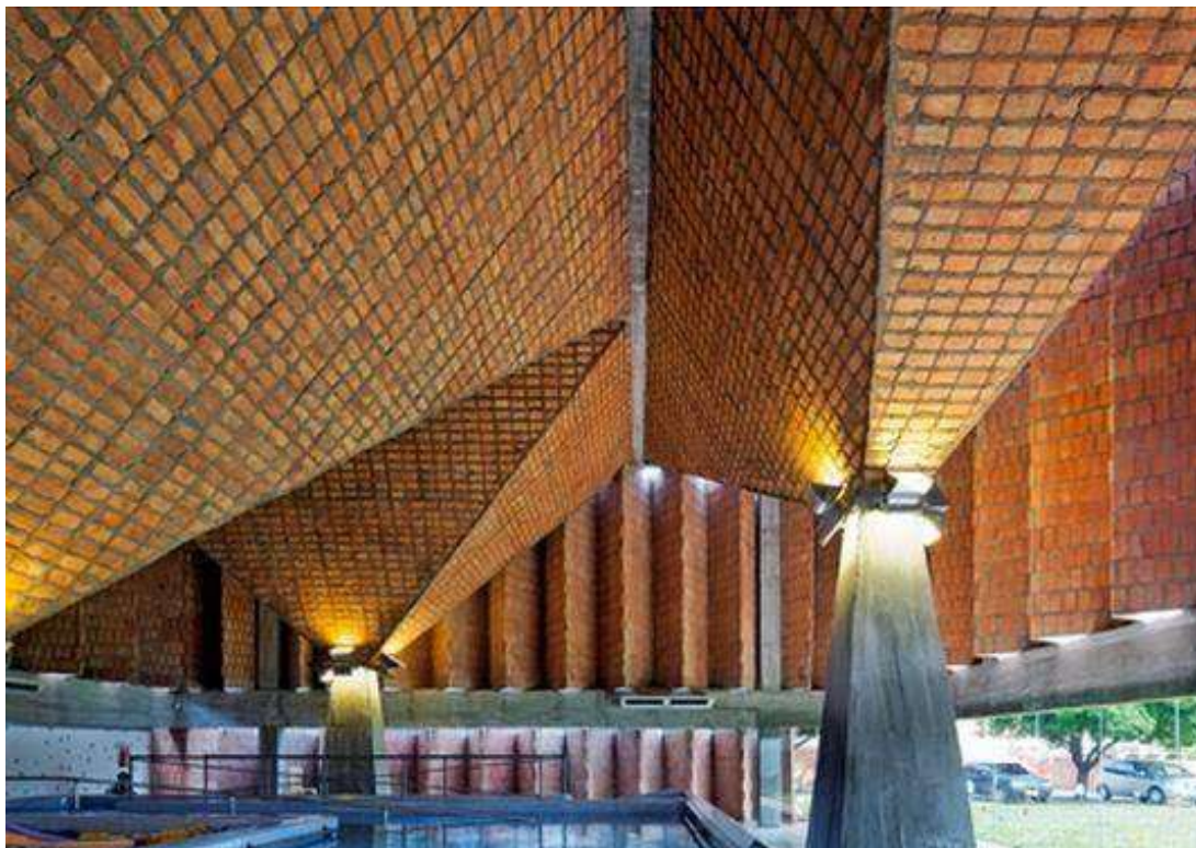
Ilustración 17 Techo de la piscina está formado por pirámides Centro de Rehabilitación Infantil de la Teletón, Lambare, Paraguay. [27/Feb2017]
