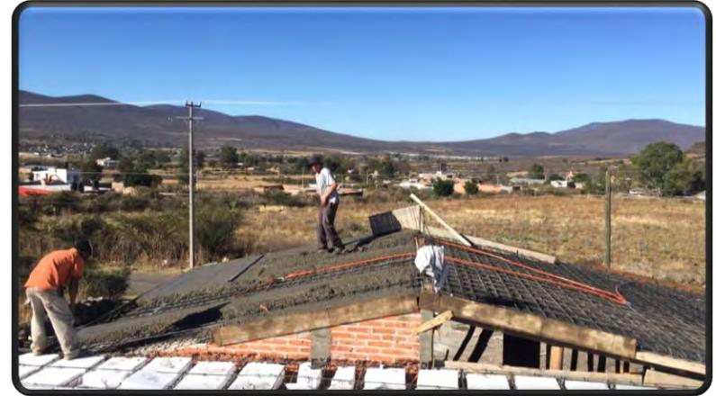
COLADO DE LOSA DE CONCRETO ARMADO Y RETICULAR
