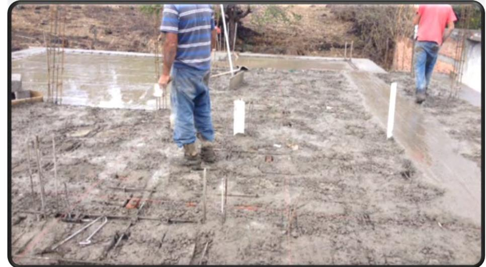
COLADO DE LOSA RETICULAR CON BLOCK DE 15 CM.
