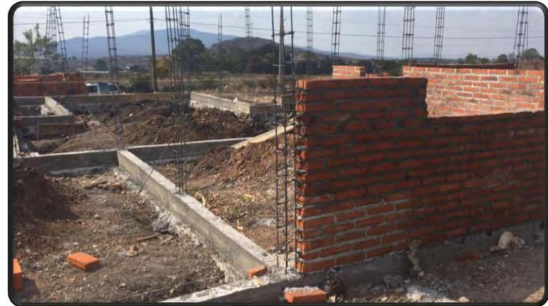
DESPLANTE DALAS Y MURO DE TABIQUE CON APLICACIÓN DE CARTON ASFALTICO
