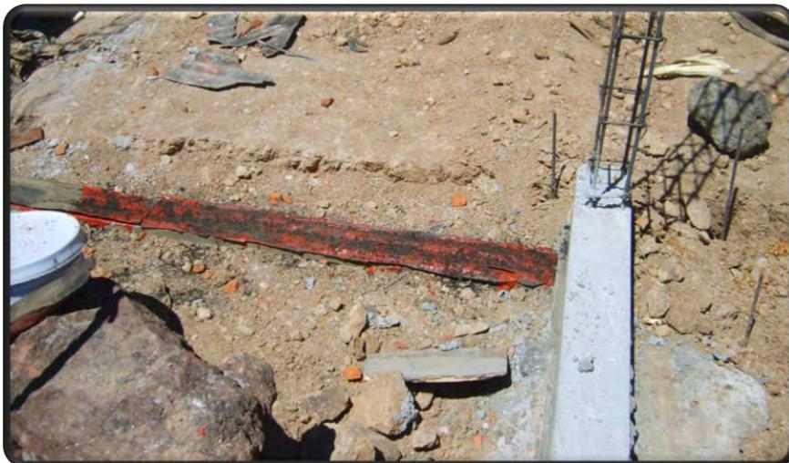
DALASY APLICACIÓN DE CARTON ASFALTICO COMO SISTEMA DE IMPERMEABILIZACION
