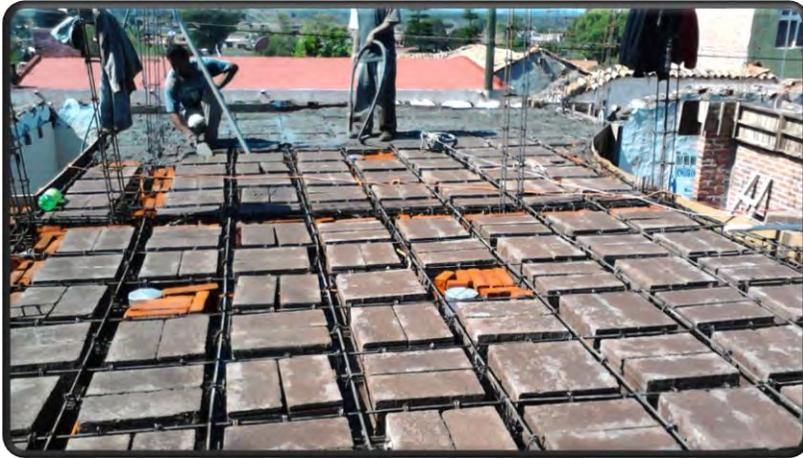
COLADO DE LOSA RETICULAR CON SISTEMA DE VIBRADO
