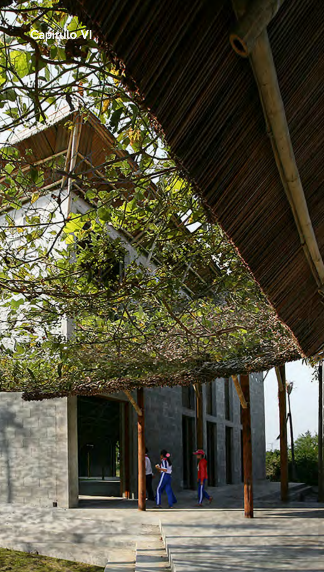
Fig. 52 Casa Comunitaria Cam Thanh. Se destaca la estrategia de control de asoleamientos por medio de cubiertas verdes permeables. Recuperado desde: http://www.archdaily.mx/mx/768157/casa-comunitaria-de-cam-thanh-1-plus-1-2
