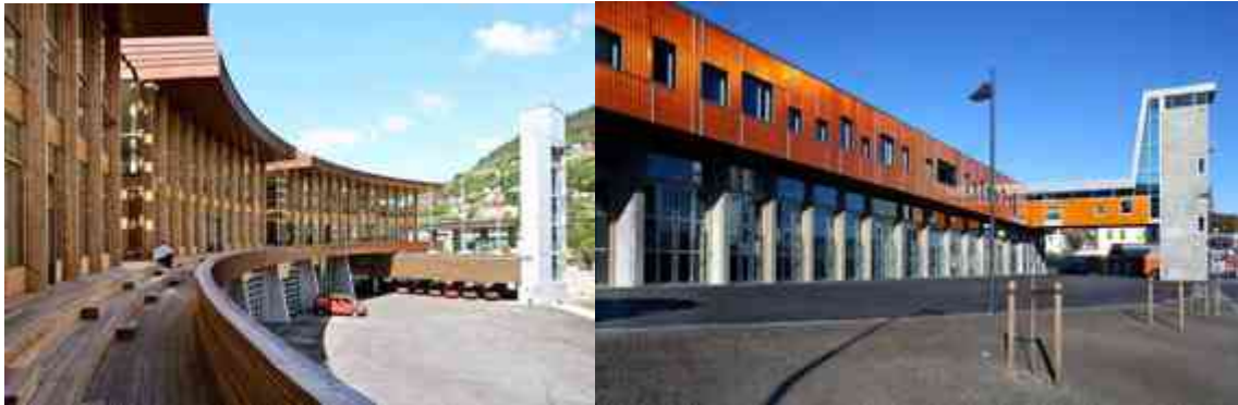
Ilustración 20/ torre y patio de maniobras/ google imágenes
