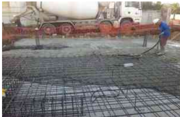
Ilustración 72/ losa de cimentación/ google imágenes
