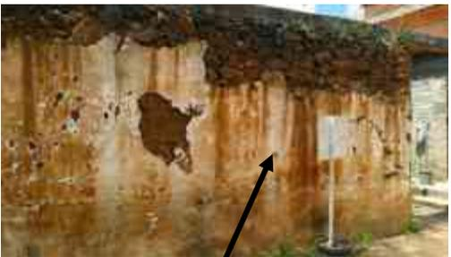
Muro de mampostería con recubrimiento de barro y aplicación de mezcla con acabado en pintura blanca
