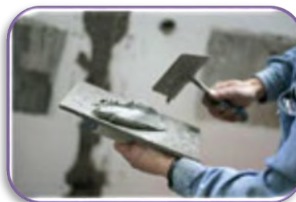
Ilustración 66 Aplicación de yeso www.construccion.com.mx
