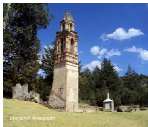
Foto 6: Ruinas de la torre del templo de la señora del Carmen.
