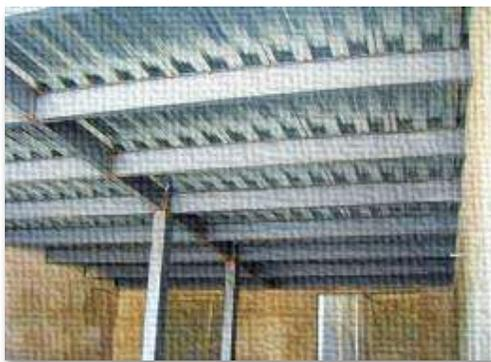
Imagen 32 Estructuras de acero con perfiles HSS (Disponible en <http://techadosycubiertas.com.mx/wp-content/uploads/2015/08/Diapositiva21-300x225.png>)
