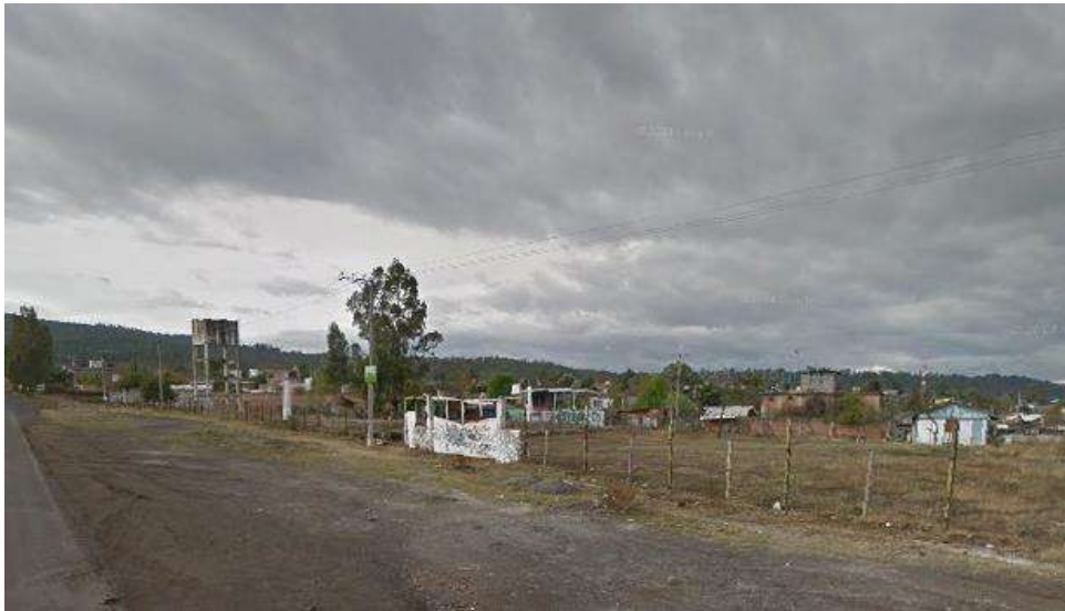
Figura 42. Se observa calles sin pavimentación. Fuente: Autor
