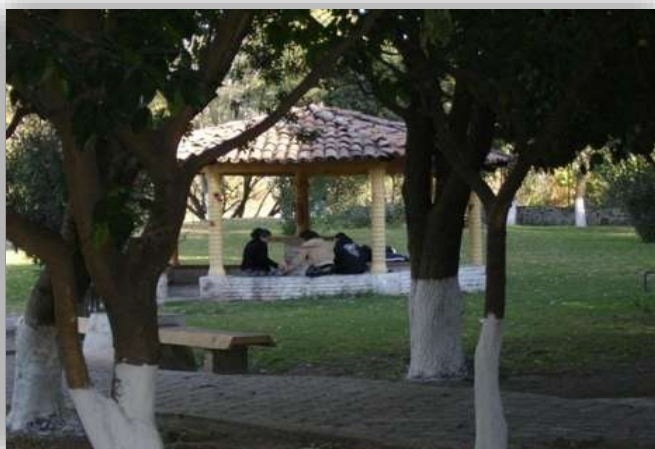
Fig. 128. La mayoría de los kioscos están hechos con materiales reciclados y/o donados, en este caso las columnas son de tubería de cemento. Juan Alberto Alduenda Sánchez.
