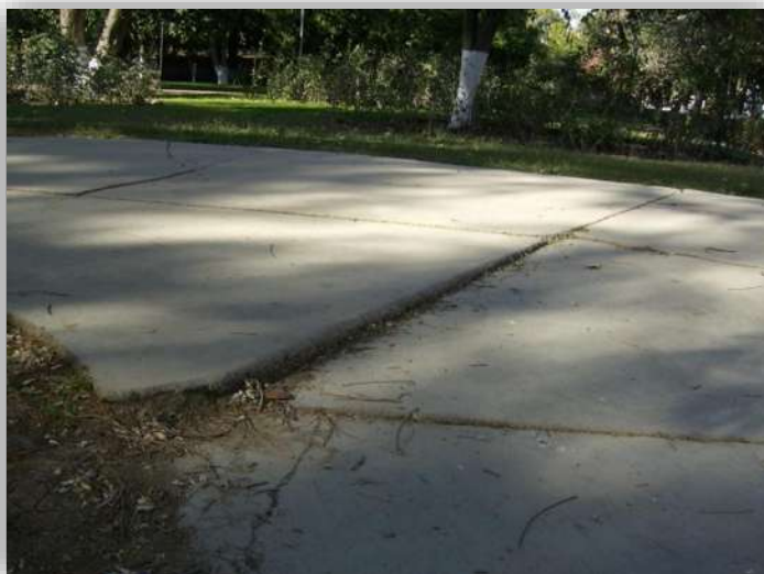
Fig. 121. El problema más común que se observa es el hecho de que las raíces han levantado el piso, tanto las placas de concreto como el adoquín, haciendo que algunas actividades sean complicadas de ejecutarse. Juan Alberto Alduenda Sánchez.
