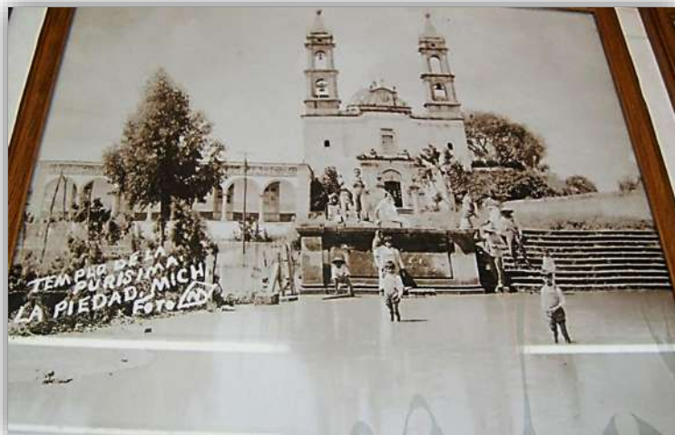
Fig. 87. Fotografía tomada en 1912 donde se muestra parte de la inundación en el templo de la purísima.
