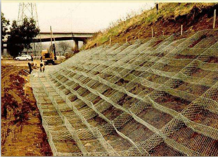
Fig. 40. Construcción de los gaviones, que fue la solución definitiva para los taludes del cauce del arroyo. Víctor M. Ponce.
