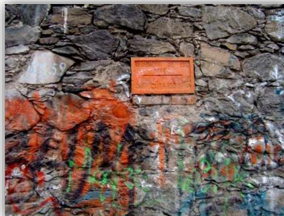
Fig. 89. Registro de la inundación de 1912 en el muro de la empresa Turbomaquinas. Arq. André Aguilar Aguilar.
