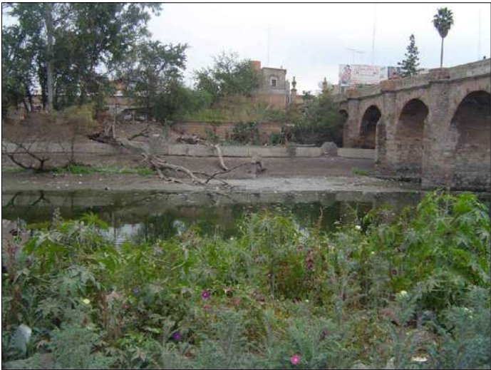
Zona próxima del puente Cabadas
