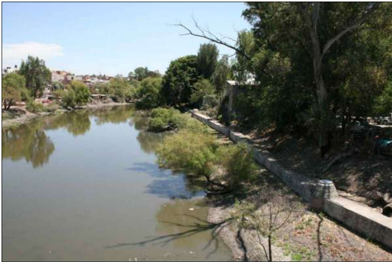
Vista desde el puente Cabadas
