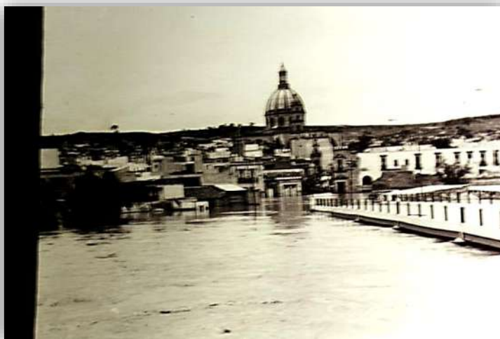
Fig. 93. Imagen de la inundación de 1973 en donde se muestra como el agua empieza a cubrir el puente en construcción. Julio Cesar Sandoval
