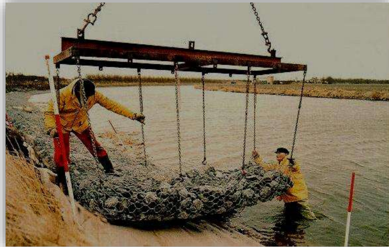
Fig. 41. Se aprecia como los gaviones también pueden ser utilizados a la orilla del río y bajo el agua. Víctor M. Ponce.
