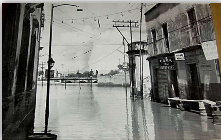
Fig. 94. Fotografía tomada desde la calle Morelos. Al fondo se observa el puente Cabadas y el puente Morelos, que se encontraba en construcción. Julio César Sandoval.
