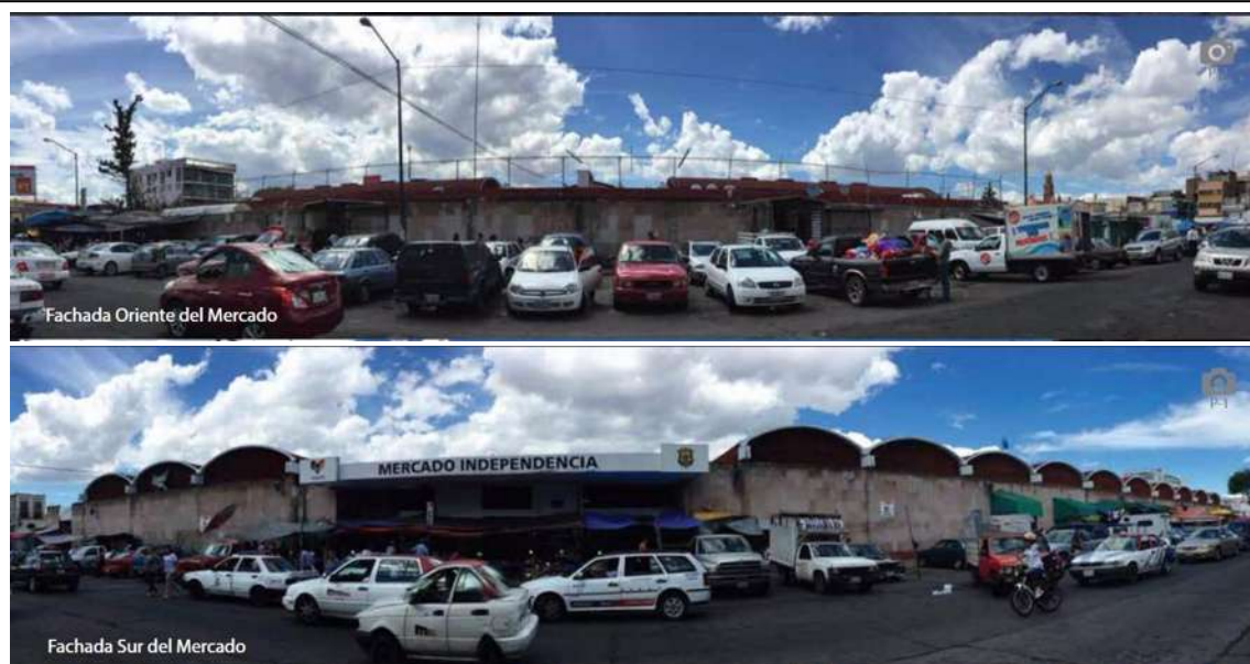
Foto 1.11. Fachadas del mercado independencia Fuente: https://issuu.com/jaimealberto3/docs/an_lisis_de_sitio_mercado_independ [04/10/16]
