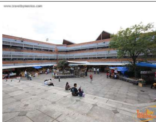
Figura 1.2. Plaza principal de acceso del mercado Fuente: http://www.travelbymexico.com/blog/imgBase/2008/04/IMG_4004.jpg [04/10/16]
