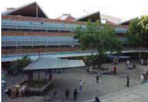
Foto 1.6. Vistas de fachada lateral Fuente: http://structurae.net/structures/data/index.cfm?id=s0029648 [04/10/16]
