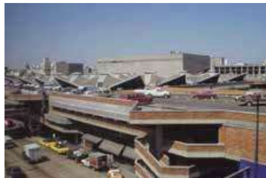
Foto 1.7. Vistas de fachada lateral Fuente: http://structurae.net/structures/data/index.cfm?id=s0029648 [04/10/16]
