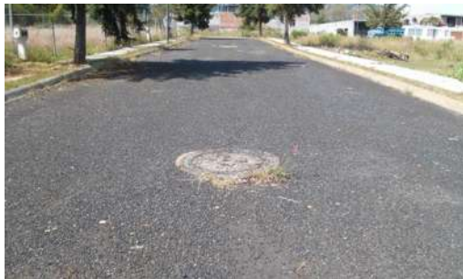
Fig. 4.12 Pozo de visita Foto: L.L.M. [08/11/16]
