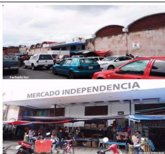
Foto 1.12. Fachada sur estado actual Fuente: https://issuu.com/jaimealberto3/docs/an__lisis_de_sitio_mercado_independ [04/10/16]
