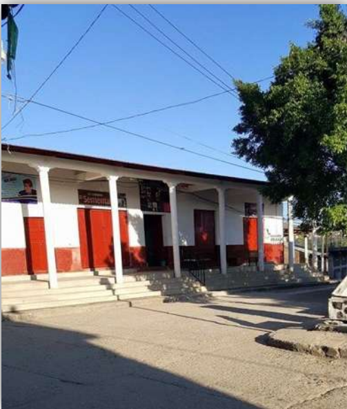
Imagen 28. Portales de zona centro de Tumbiscatío, se puede observar que el uso de suelo que predomina es habitacional mixto
