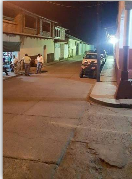
Imagen 27. Concreto hidráulico en calle Presidente Kennedy
