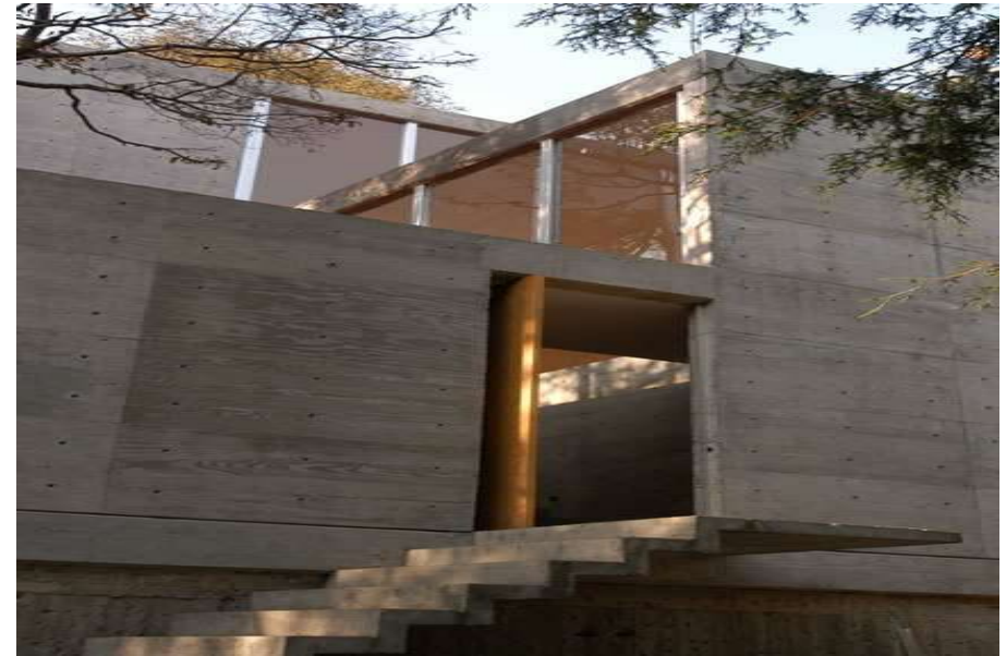
Img.63. ENLACE ARQUITECTURA, concreto aparente – utilidades, ENLACE 2016.
