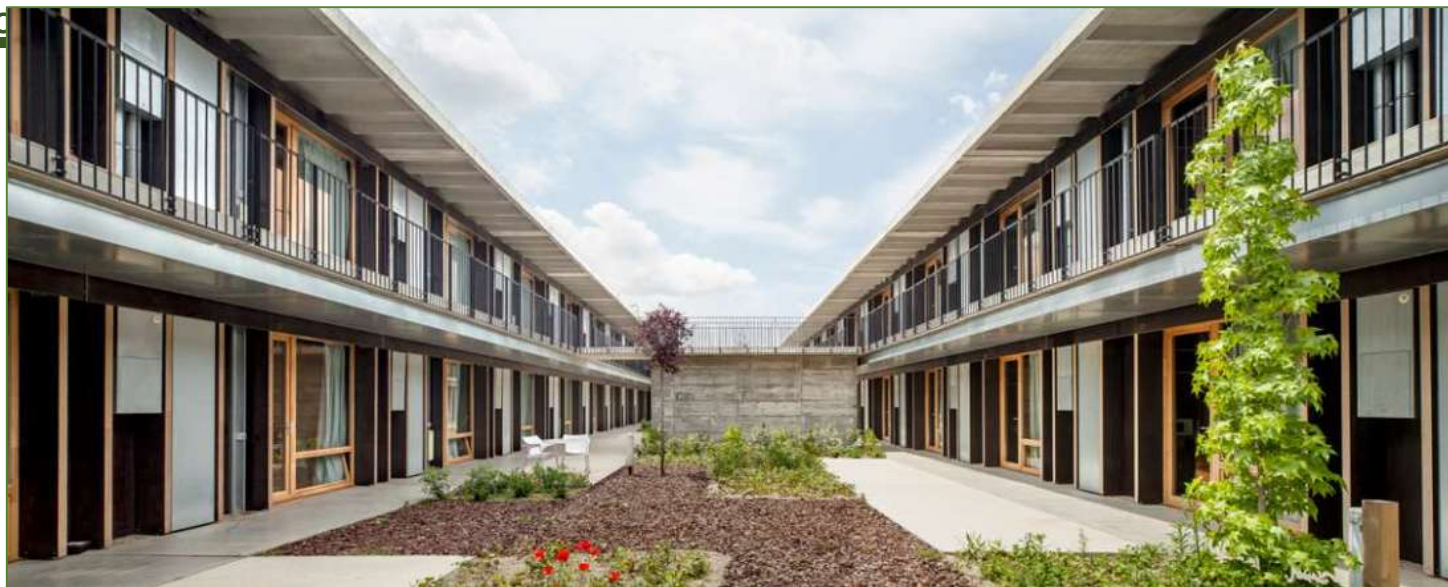
Img.43. Atrio interior y comunicaciones. Viviendas universitarias en Sant Cugat del Vallès, por dataAE + HARQUITECTES. Fotografía © Adrià Goula.
