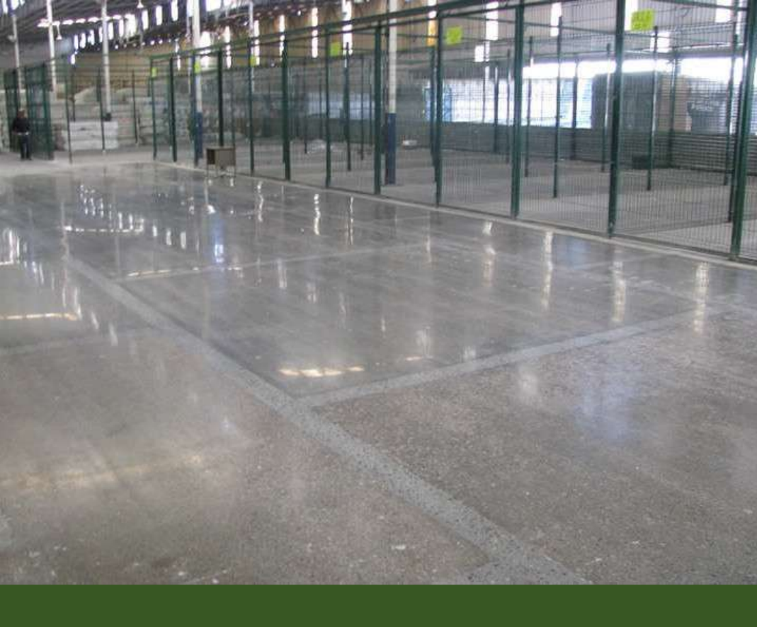
Fig. 36, Concretos pulidos kisko, acabados residenciales arquitectónicos, 2013 Madrid España, www.kiskoconstrucciones.com
