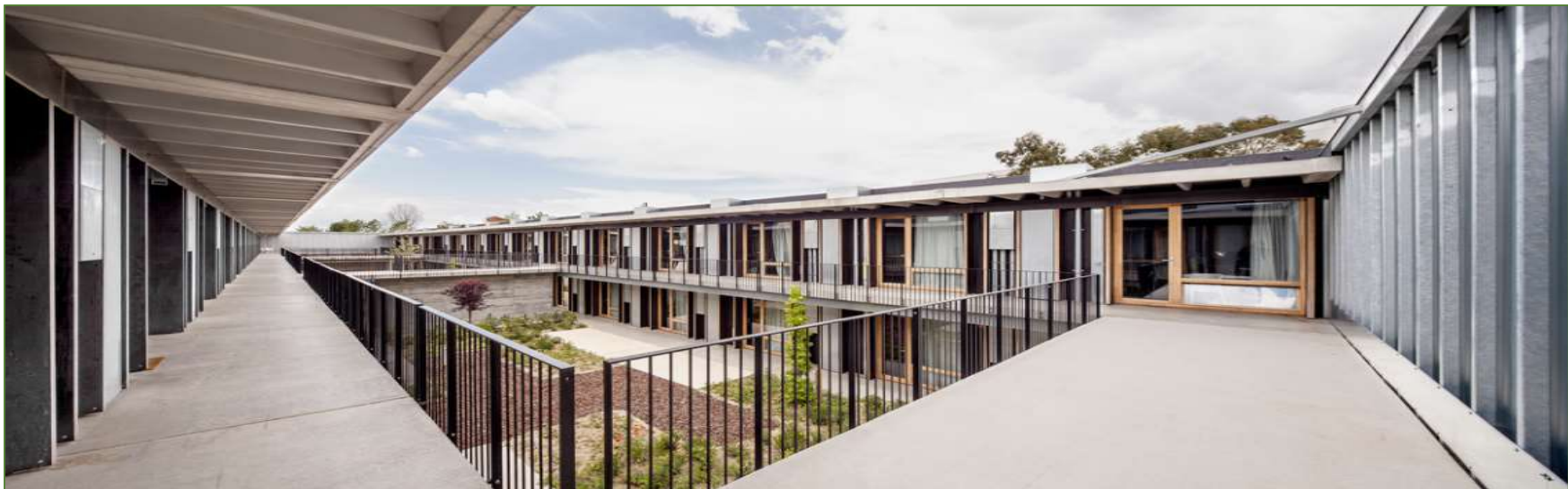
Img.42. Galería superior. Viviendas universitarias en Sant Cugat del Vallès, por dataAE + HARQUITECTES. Fotografía © Adrià Goula.
