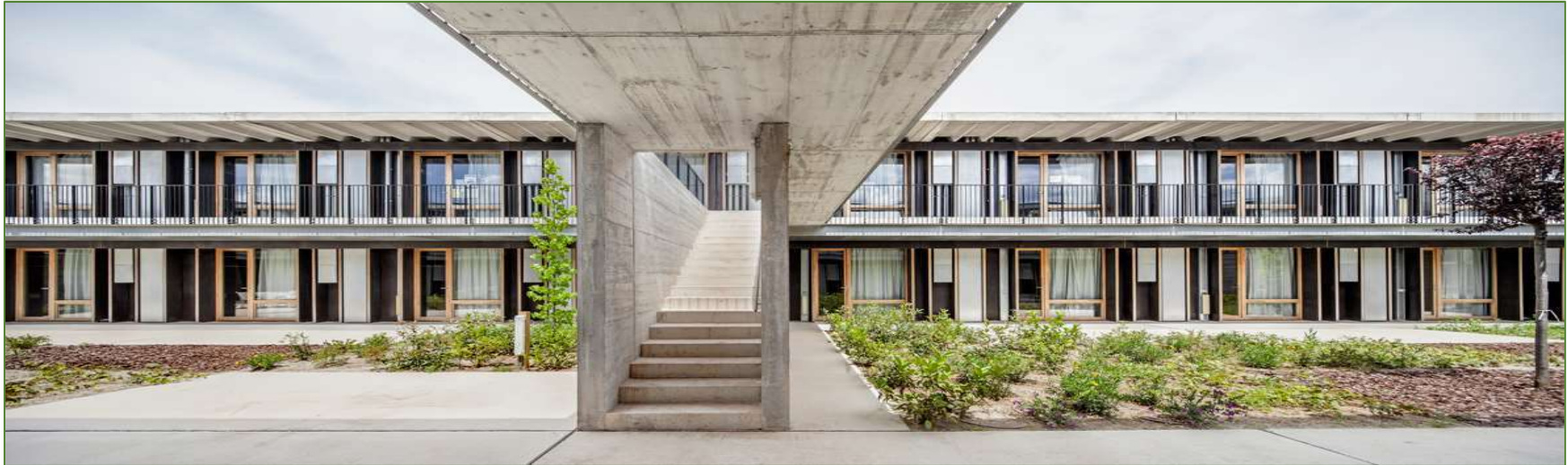
Img.41. Atrio interior y comunicaciones. Viviendas universitarias en Sant Cugat del Vallès, por dataAE + HARQUITECTES. Fotografía © Adrià Goula.
