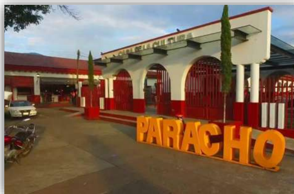
Ilustración 90: Fachada de la Casa de la Cultura.
