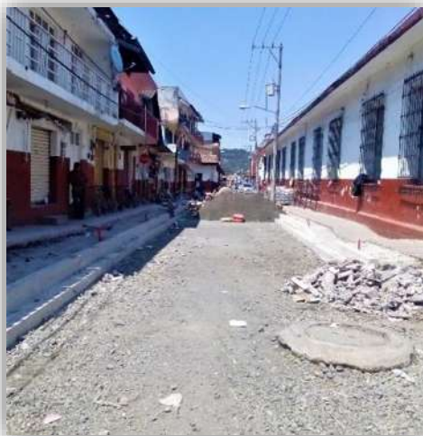
Ilustración 34: Calle Amado Nervo, En trabajos de mejoramiento. Fuente: Marisol Estrada Jasso.
