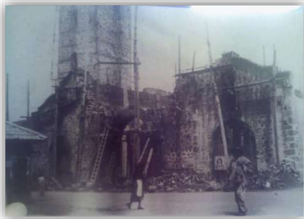
Ilustración 83: Construcción del Templo en 1946.
