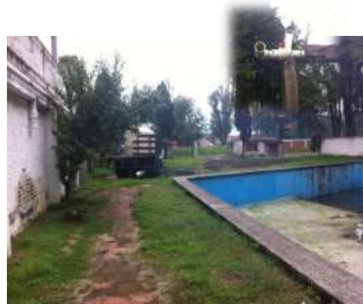
Foto. X. Toma de agua CDC. Elaboración propia.
