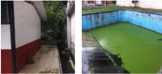
Fig. VI. Estado actual albercas. Elaboración propia
