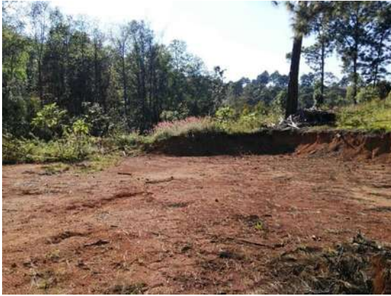
Imagen 68. Planicie 2 realizada con retroexcavadora.
