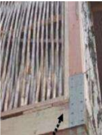
6. Colocación de platinas.
