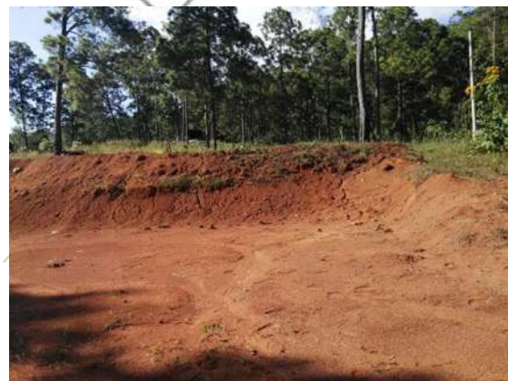
Imagen 67. Planicie 1 realizada con retroexcavadora.
