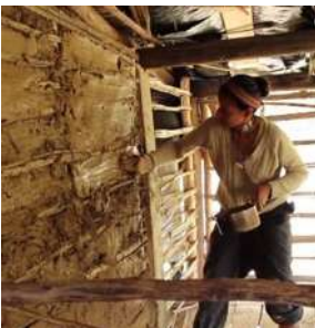
7. Revestimiento de paneles
