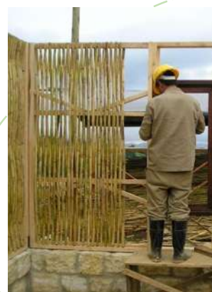
4. Montaje de paneles.
