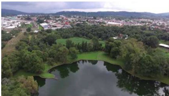
Imagen 11. Presa de santa Catarina; vista aerea.
