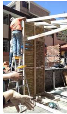
1. Armado de panel tipo.
