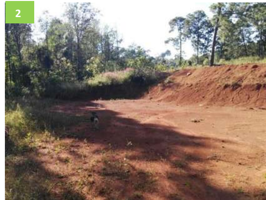
Imagen 37. Vista 2, planicie generada con retroexcavadora.
