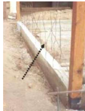
3. Anclaje de paneles
