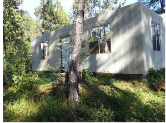
Imagen 75. Cabaña en construcción dentro del terreno.
