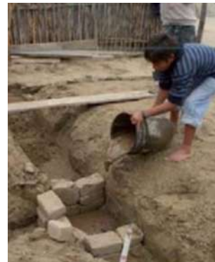
2. Cimentación y columnas.
