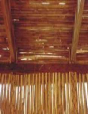
5. Colocación de malla de alambre.
