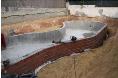
2. Construcción de vaso
