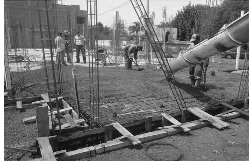
Ilustración 46: Losa de cimentación. BMAF
