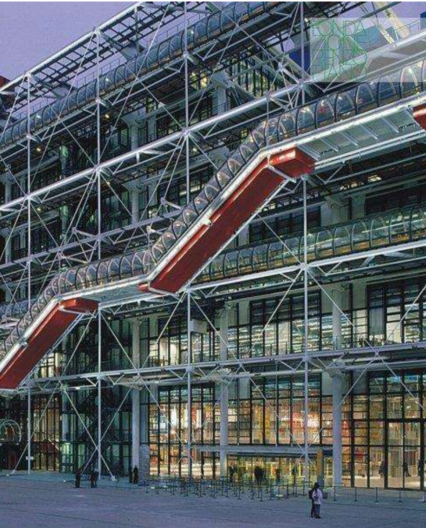
Figura7 | Acceso principal Centre Georges Pompidou.
