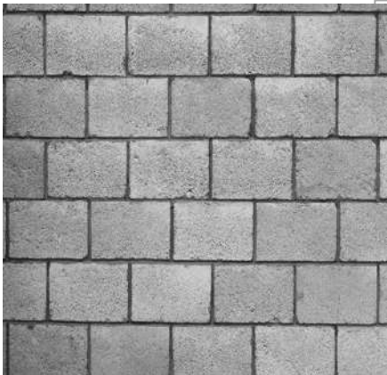
Figura 60 | Muro de block de concreto.
