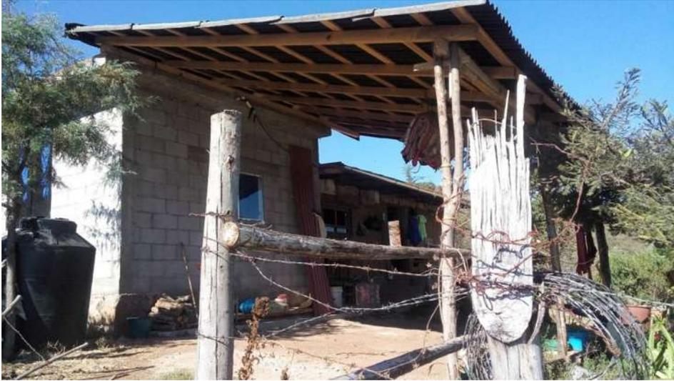
Fig. 32. Casa construida con apoyos de block y un cuarto de adobe. Tienen baño seco y fósca séptica, también utilizan la captación de agua pluvial en el solar que tienen.
