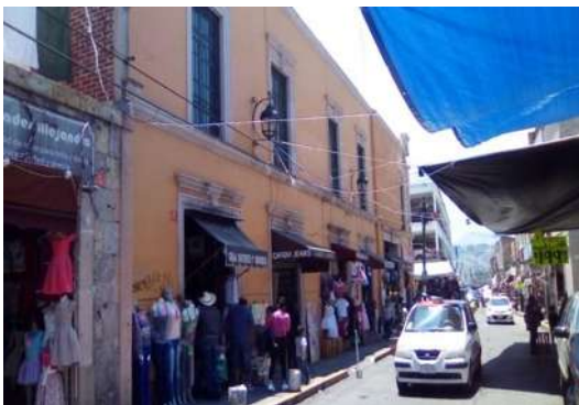
CALLE ANDRÉS DEL RÍO PLAZA COMERCIAL "EL VALOR" FACHADAS.
