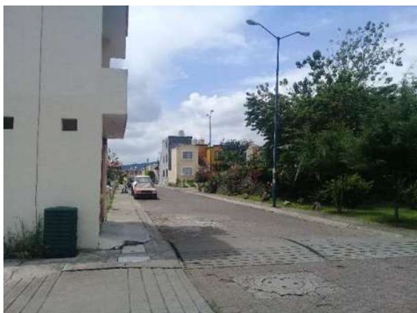
Imagen 38- Vista hacia la zona habitacional ubicada al sur del terreno. Fuente: Tomada por TPSP el día 29/10/2017.
