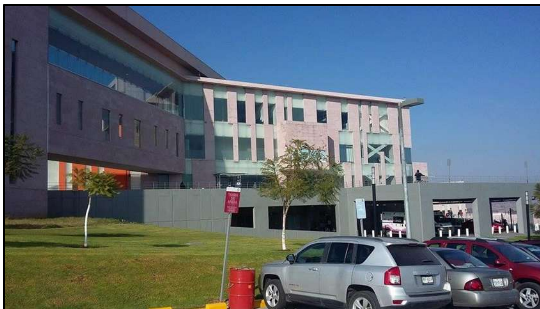
Imagen 7. Fachada exterior Sur HGR No. 1 Lugar; Municipio de Charo, Michoacán Autor: JCHF 25/Noviembre/2017
