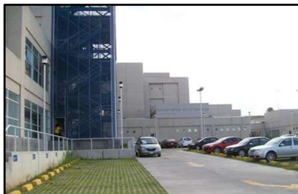
Imagen 20. Fachada Posterior Hospital Regional ISSSTE
