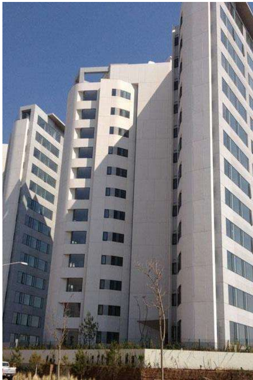
Ilustración 73. Fotografía exterior de Torres Panorama. Foto: Casas Travit
