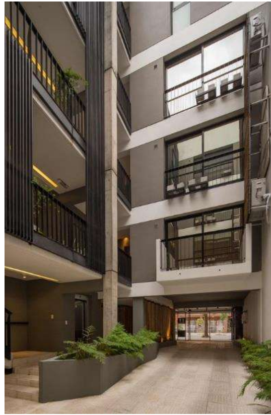
Ilustración 56. A Cceso visto desde el patio central. [http://www.archdaily.mx/mx/871632/edificio-mz3268-cubero-rubio] Fecha de consulta: Septiembre 19, 2017.
