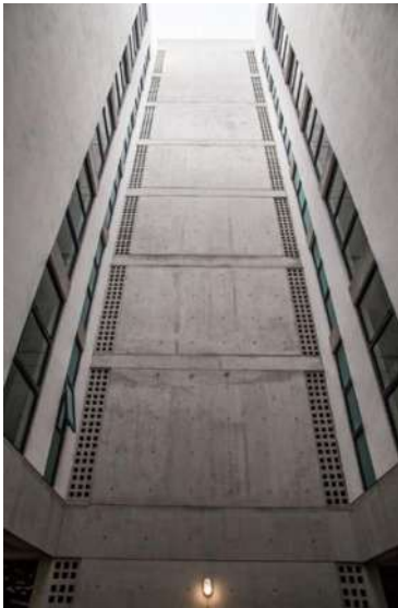
Ilustración 65. Vista lateral desde el patio central Fuente: [http://www.archdaily.mx/mx/878613/barranca-del-muerto-14-dmp-arquitectura/59a4746bb22e38a2dc0004d7-barranca-del-muerto-14-dmp-arquitectura-imagen] . Fecha de consulta: Septiembre 19,2017.
