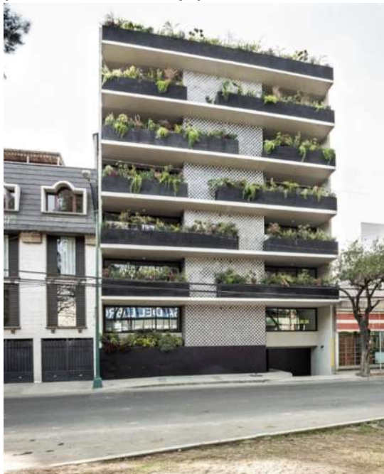
Ilustración 63. Fachada principal Barranca del Muerto 14. Foto: Omar Chavez Godoy. Fuente: [http://www.archdaily.mx/mx/878613/barranca-del-muerto-14-dmp-arquitectura/59a4746bb22e38a2dc0004d7-barranca-del-muerto-14-dmp-arquitectura-imagen]. Fecha de consulta: Septiembre 19, 2017.
