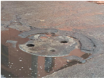
Registros y coladera.
