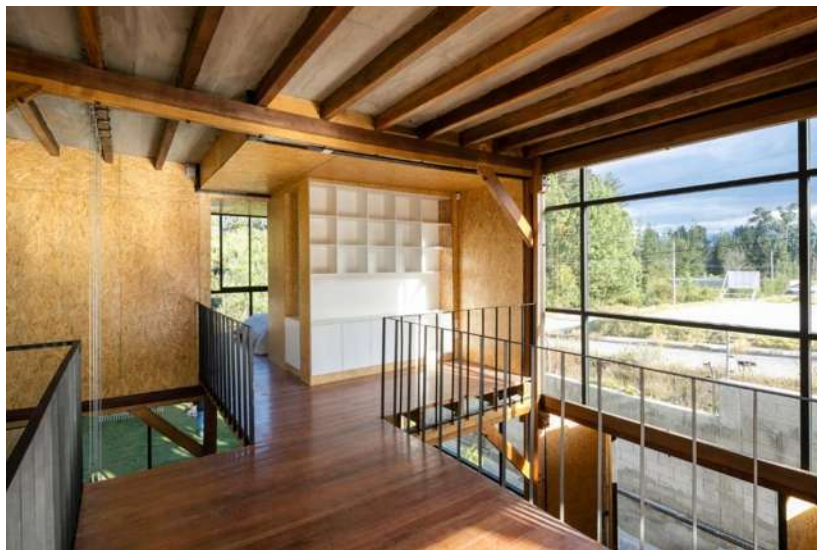
Ilustración 65: Losa con madera cuatrapeada, Fuente: https://www.construyehogar.com/planos/diseño-casa-económica-de-dos-pisos/ , (2018).
