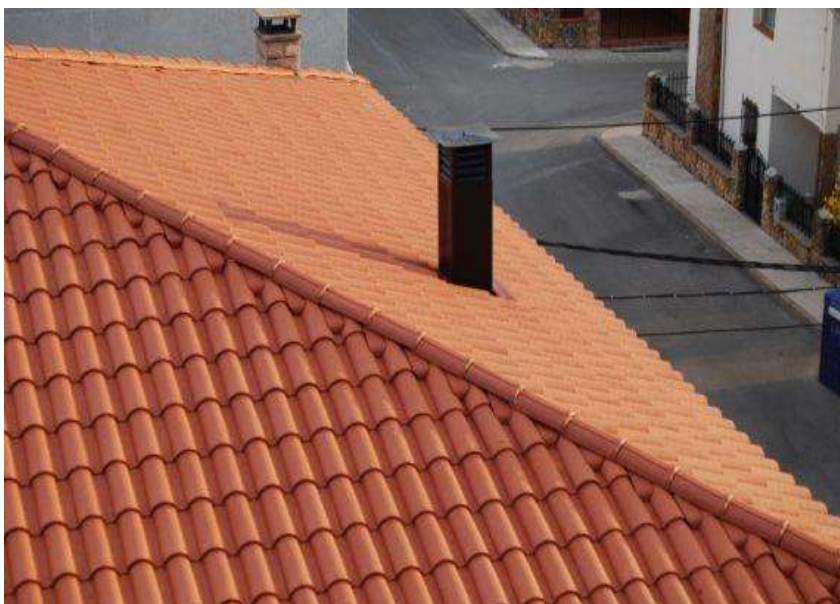
Ilustración 66: Cubierta con teja, Fuente: https://www.tejadosmanchegos.es/tag/chimeneas/ , (2018).
