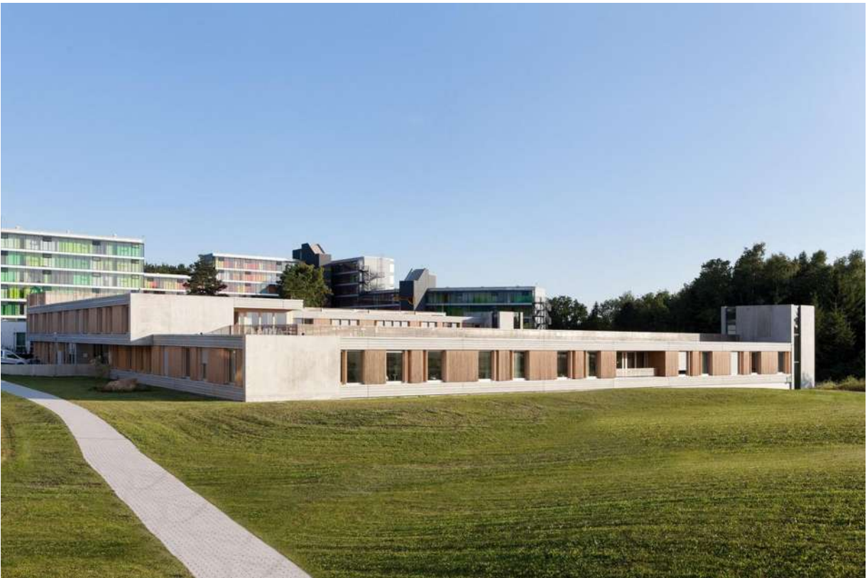
Imagen 07. Fachada Trasera del Edificio
