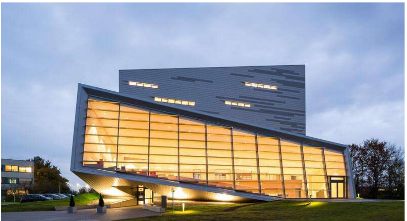
Imagen 01: Fachada Principal del edificio Family House Sankt Augustin
