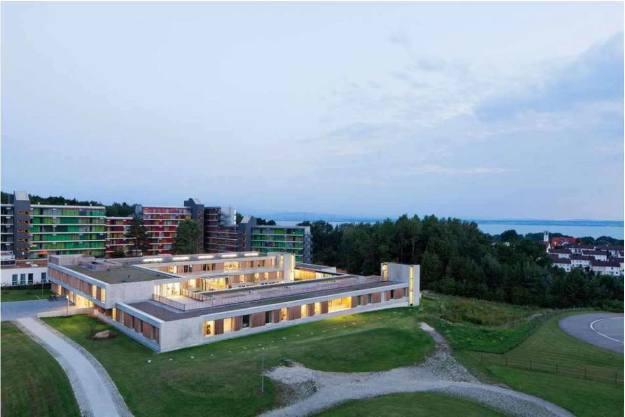
Imagen 06. Vista Aérea Exterior. Centro Psiquiátrico Friedrichshafen
