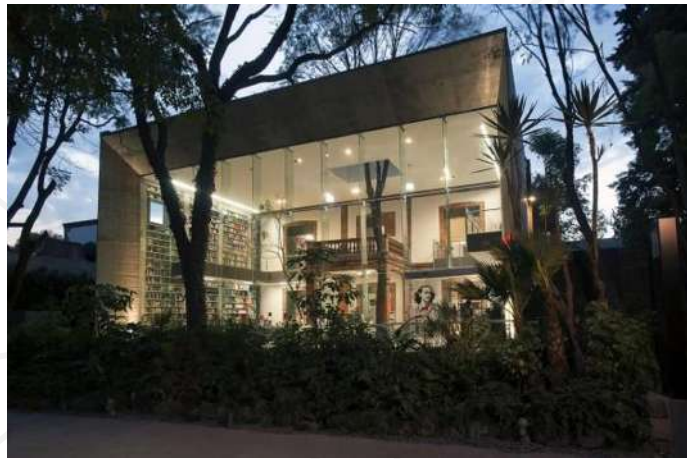
Imagen 31. Centro Cultural Elena Garro, diseñado por Fernanda Canales y arquitectura911sc. www.archdaily.mx
