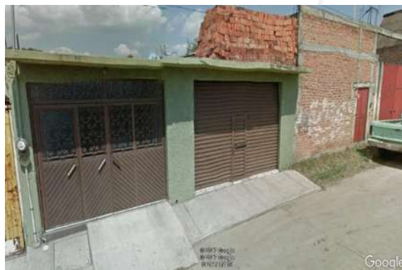
Foto 06. Fachada de concreto y de tabique. Foto tomada de Google Earth Pro.
