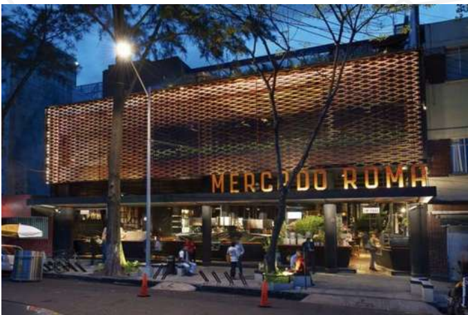
Imagen 34. Fachada principal del Mercado Roma, Rojkind Arquitectos. mxcity.mx
