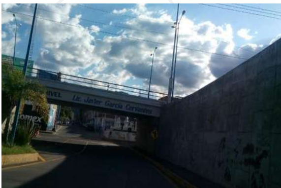
Foto 21. Paso a desnivel vehicular. Foto de elaboración
