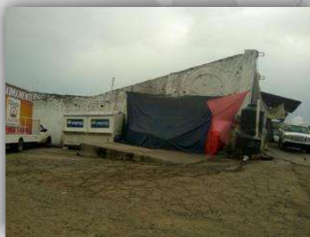
IMAGEN 18. Imagen urbana de la actual central. Fuente: Imagen del autor, 14/09/17.
