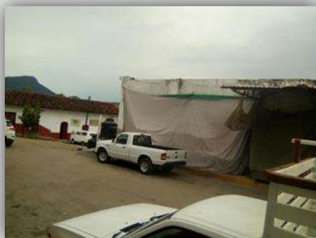
IMAGEN 17. Imagen urbana de la actual central. Fuente: Imagen del autor , 14/09/17.
