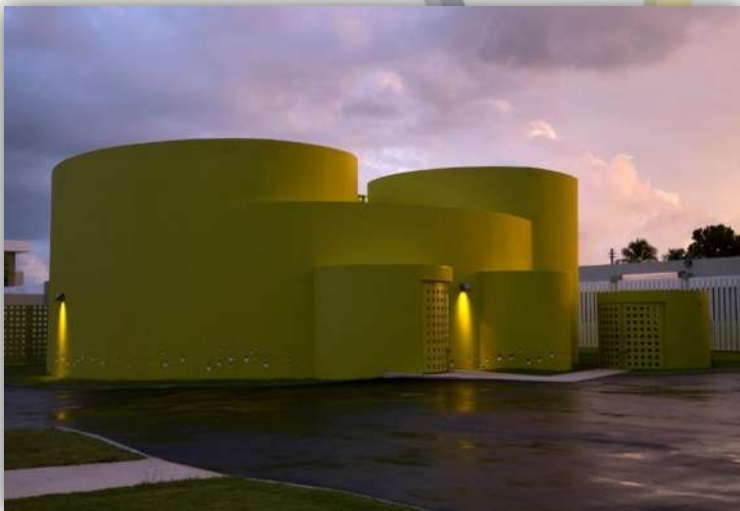
Imagen 6.06. Volumetría en fachadas. Obtenida de: https://www.archdaily.mx/mx/777685/piscinas-terapeuticas-para-escuela-la-esperanza-fuster-plus-architects/564d2411e58ece8c4200026d-therapeutic-pools-for-la-esperanza-school-fuster-plus-architects-photo
