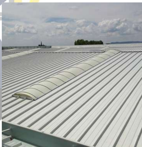
Imagen 5.03 Lámina acanalada en cubierta. Obtenida de: https://www.google.com.mx/search?q=lamina+acanalada+en+cubiertas&source=lnms&tbm=isch&sa=X&ved=0ahUKEwjJIYnT9-XdAhVHL6wKHTBQAUeQ_AUICigB&biw=1396&bih=686#imgsrc=ErlEvLOb-KscNM : (20 de Agosto del 2018).
