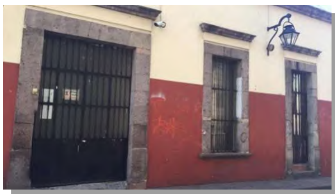
Fig. 1 Fachada de la vivienda, Iglesia Palabra Miel Morelia. Fotografía por VMH.
