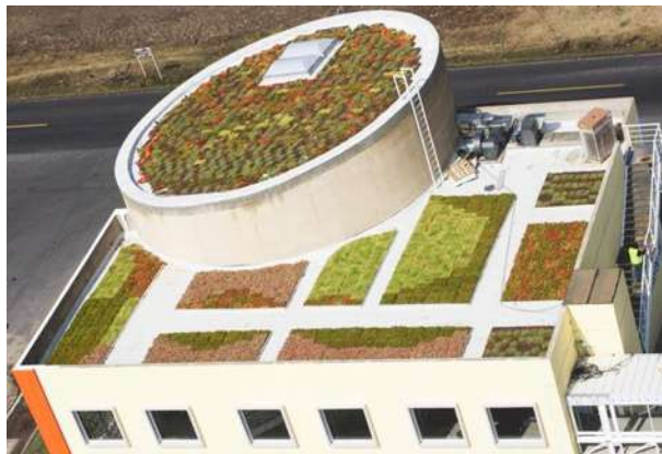
Fig. 11 Sistema de azotea verde
