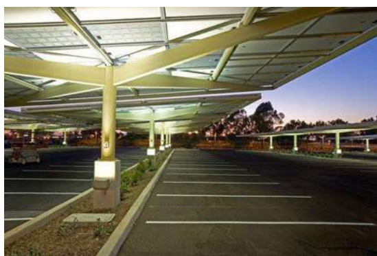
Imagen 53. Colocación de banquetas o protecciones para las columnas en estacionamientos. Fuente: http://www.arqhys.com/construccion/vehiculos-estacionamiento.html
