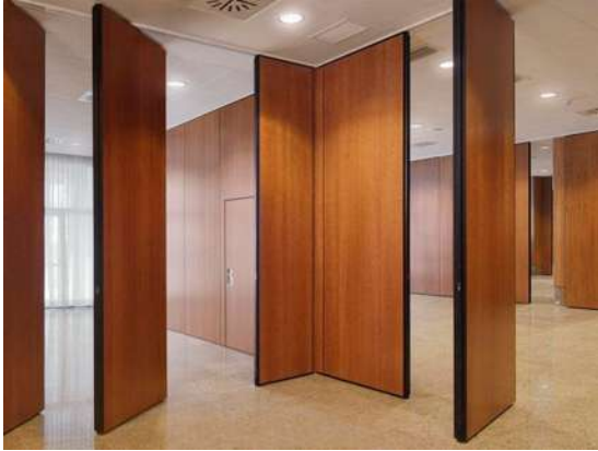
Imagen 66. Implementación de mamparas de madera. Fuente: http://www.mamparasdivisoriasmadrid.com/
