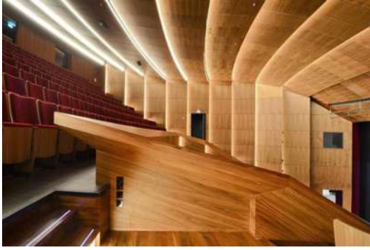
Imagen 67. Aplicación de elementos de madera en plafones y muros en la sala de eventos de un teatro.
