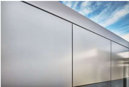
Imagen 64. Aplicación de los paneles Alucobond en una muro de fachada. Fuente: https://www.alucobondusa.com/blog/new-harwyn-alucobond-office-pods-continue-to-revolutionize-modular-design/#.WhENY8bibIU
