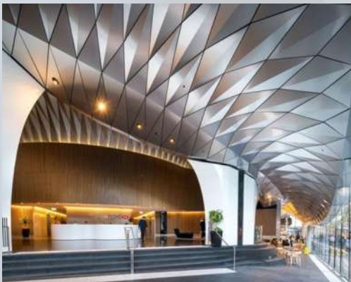
Aplicación del panel Alucobond en claros grander.
