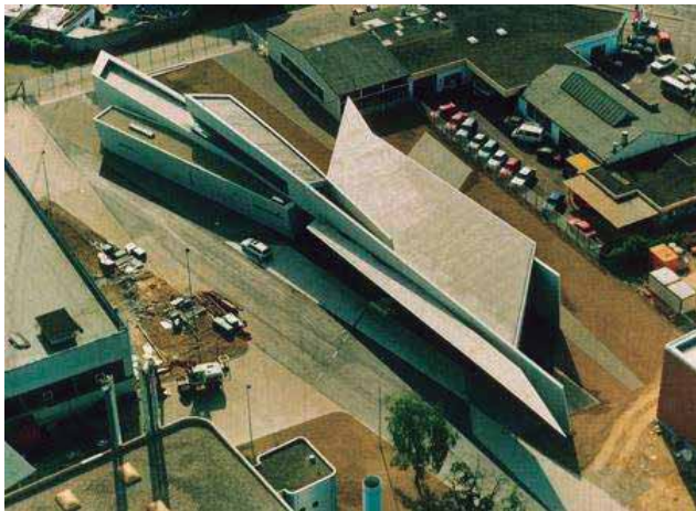
Ilustración 6 “Vista aérea de la Estación de Bomberos Vitta” Fuente de consulta: https://es.wikiarquitectura.com Fecha de Consulta: [octubre del 2017]
