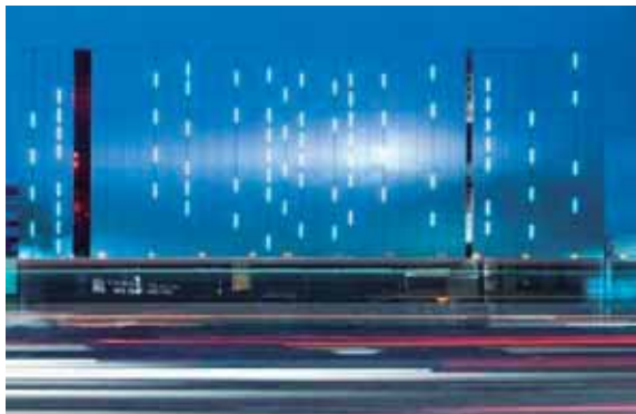
Ilustración 7 “Fachada de la Estación de Bomberos Ave Fenix” Fuente de consulta: https://www.archdaily.mx Fecha de consulta: [octubre del 2017]
