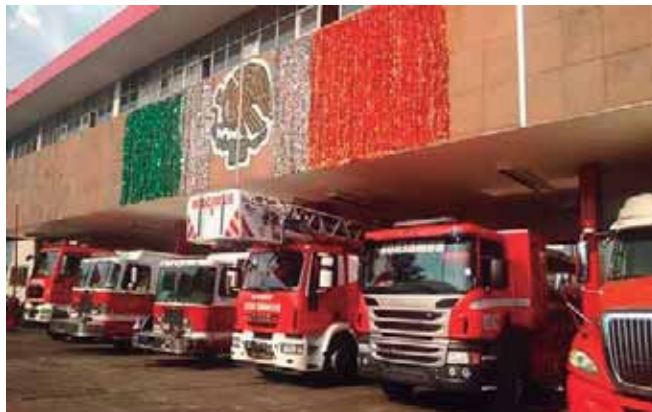
Ilustración 3 Estación de bomberos “Comandante Leonardo del Frago” Fuente de Consulta: https://www.maspormas.com Fecha de Consulta: [octubre del 2017]
