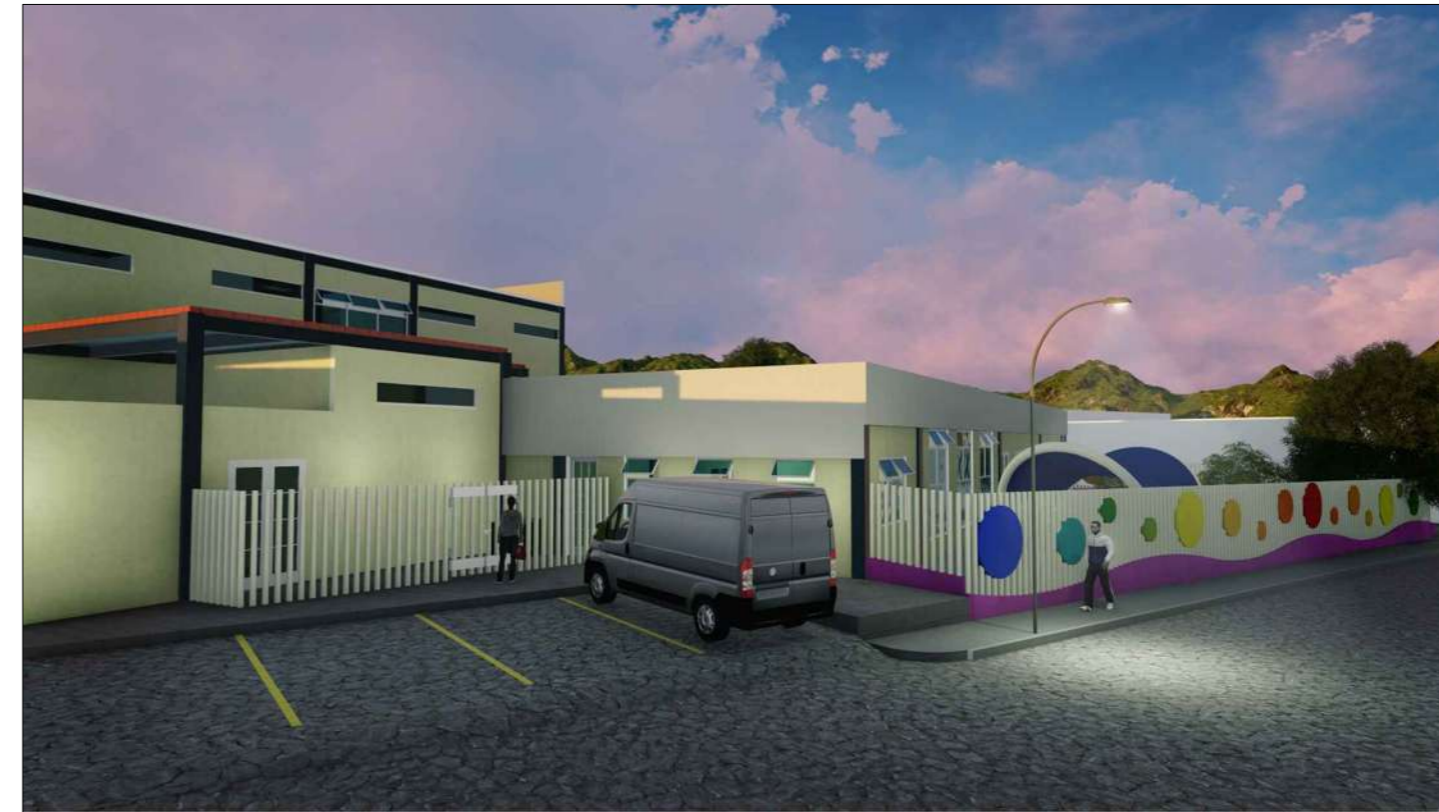
EXTERIOR, FACHADA POSTERIOR
