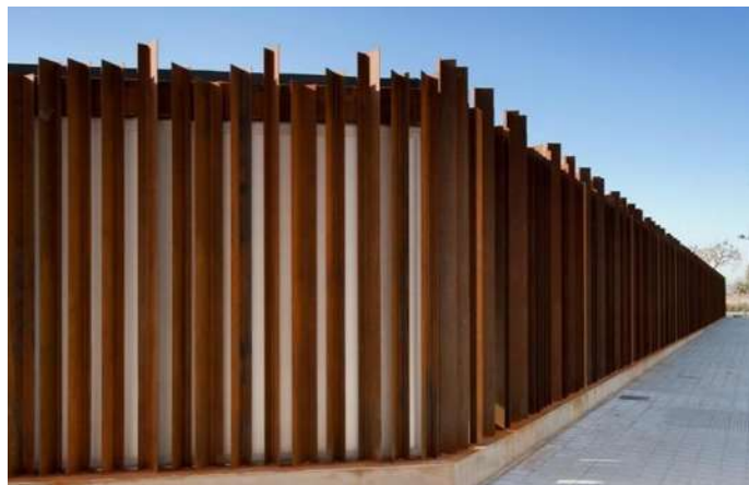
Ilustración 35. Exterior del edificio. Rstudio
