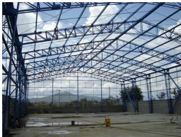
Imagen 18. Cubierta de acero
