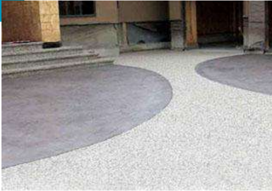
Ilustración 15. Concreto en piso.
