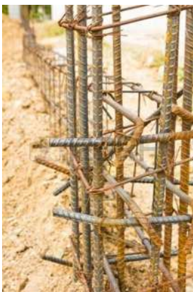
Imagen 17. Estructura de acero
