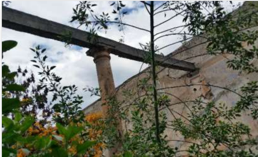
Imagen 13: Pórtico de arcos reemplazado con una trabe de concreto, sobre las columnas. Foto por autor.
