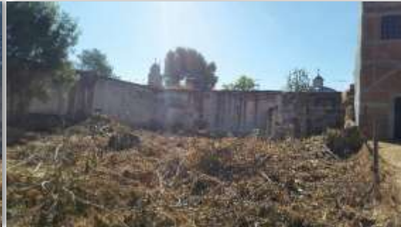
F9: muro frontal de la construcción. Foto por autor
