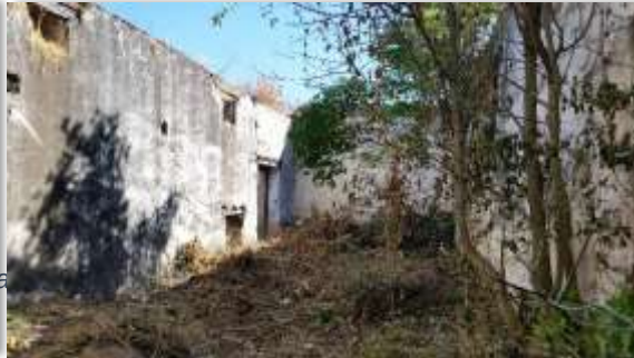
F 7: Espacio Oeste de la edificación. Foto por autor.
