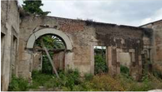
F 6: Parte Norte del patio, acceso a parte posterior de la construcción. Foto por autor
