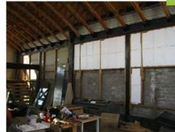
4.-Para cubrir la pared poniente del edificio, y completar el muro de block, se empleó la misma retícula de barrotes pero cubierta por Durrock en el exterior,(5) un aislante hecho con bloques de unicel recuperado y finalmente (6)un acabado de tabla roca que sería recubierto con pintura de pizarrón.
