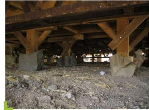
Esta trama se fija a las estructuras metálicas y de concreto previamente colocadas, y se refuerza con pilotes de madera aislados del suelo por medio de lonas que cubren a la madera curada.
