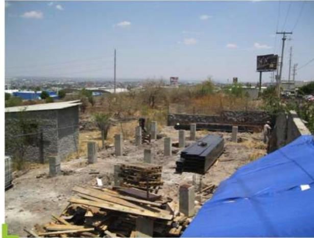
2.- La cimentación se concibió como una retícula de 15 zapatas aisladas de 90x90 armadas con varilla de 1/2" y dados de 40x40 con anclas de barilla rosca de 3/4" que se fijaran a las placas de 3/8" de las cuales se desplantan las columnas de la estructura metálica.
