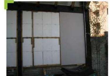
2,3.-Con estos se elaboró una retícula con separación suficiente para que se fijaran barrotes de 68.5 cm de largo para cubrir las paredes exteriores e interiores que rodean los módulos de cocina, oficina y baños.
