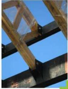
Para la colocación la estructura de madera sobre la estructura metálica fue necesario el soldar previamente piezas para sujetar los arcos en cuatro puntos, mismas que harían la función de cartabón para soportar la viga sobre las columnas metálicas. (A)
