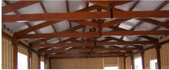
Imagen 73: Ejemplo de cubierta con cerchas de madera. Fuente: https://www.maderasmedina.com/construccion-rehabilitacion-con-madera.html#
