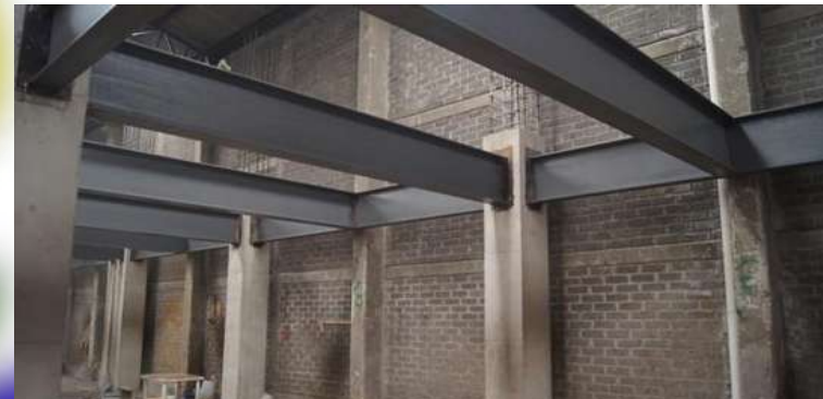
Imagen 41: ejemplo del sistema constructivo mixto, Fuente: http://www.corpacero.com/Productos/Paginas/Perlosa.aspx . FECHA: 25/06/17
