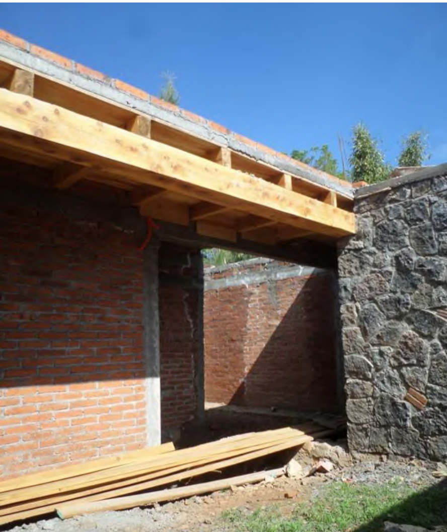
Imagen 72: Sistema constructivo mixto, muros de tabique y piedra. Fotografía: Jovani Morales Quiroz mayo 2015
