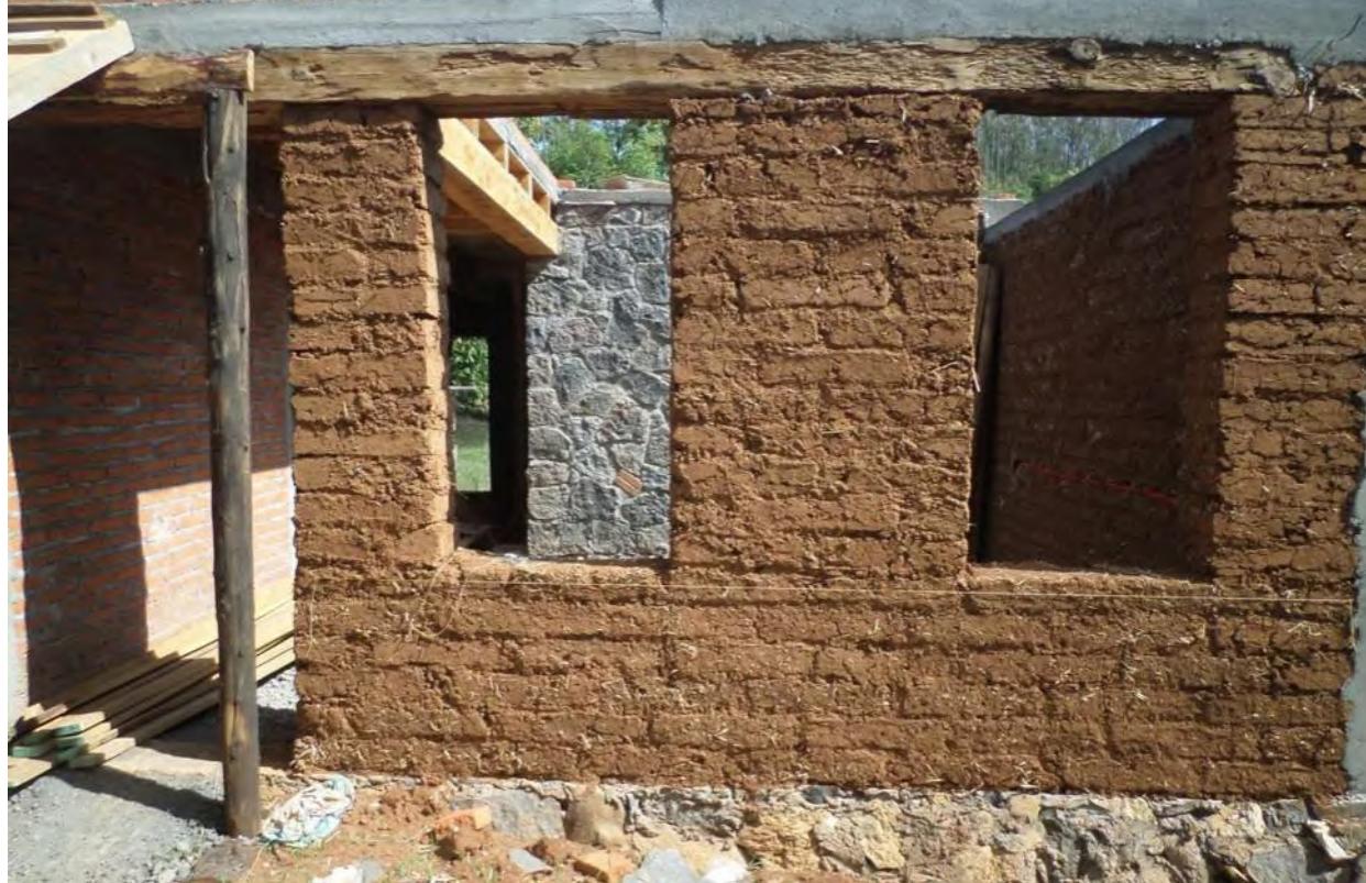
Imagen 73: Sistema constructivo muro de adobe. Fotografía: Jovani Morales Quiroz mayo 2015
