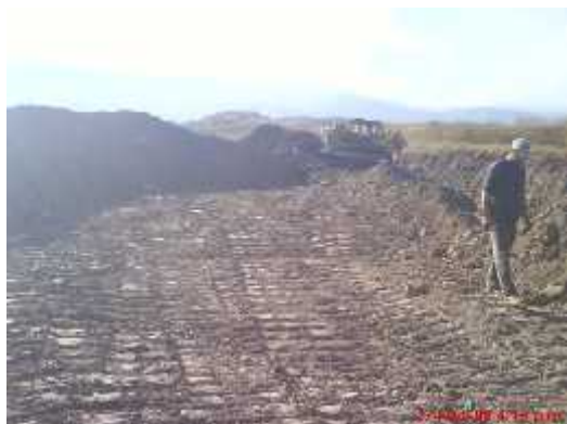
AUTOR: EDUARDO SÁNCHEZ ZÚÑIGA. FECHA 27 DE NOVIEMBRE DEL 2008, CONSTRUCCIÓN DE CELDAS EN BASURERO MUNICIPAL.
