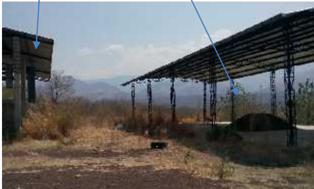
AUTOR: EDUARDO SÁNCHEZ ZÚÑIGA. FECHA 26 DE MAYO DEL 2017, NAVE DE ALMACENAMIENTO Y OPERACIÓN CITIRS DE AGUILILLA, MICH.
