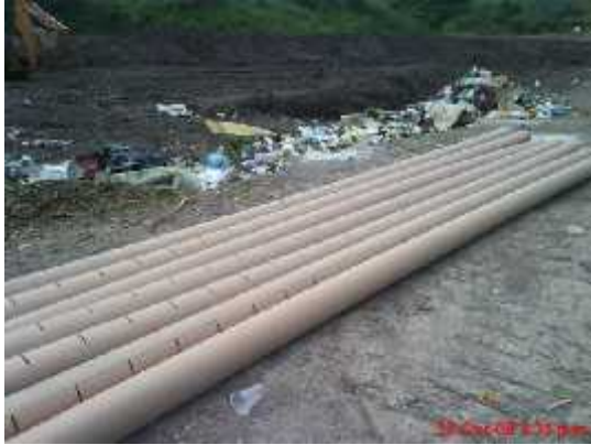
AUTOR: EDUARDO SÁNCHEZ ZÚÑIGA. FECHA 23 DE OCTUBRE DEL 2008, INSTALACIÓN DEL SISTEMA DE LIXIVIADOS, TIRADERO CONTROLADO MUNICIPAL.
