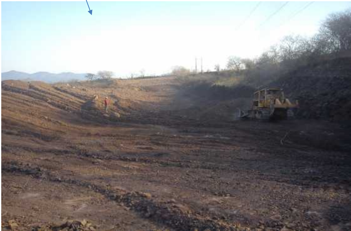
PROCESO DE FORMACIÓN DE TALUDES CON PENDIENTES DEL 35%, AUTOR. EDUARDO SANCHEZ ZUÑIGA, MARZO DEL 2011
