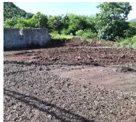
MURO DE CONTENCIÓN EN NAVE DE PLANTA DE SEPARACIÓN. AUTOR. EDUARDO SANCHEZ ZUÑIGA, AGOSTO DEL 2011
