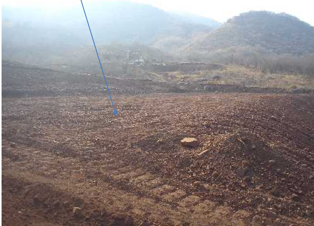
PROCEDIMIENTO DE CONSTRUCCIÓN DE PATIOS VITA HACIA EL SUR. AUTOR. EDUARDO SANCHEZ ZUÑIGA, FEBRERO DEL 2011
