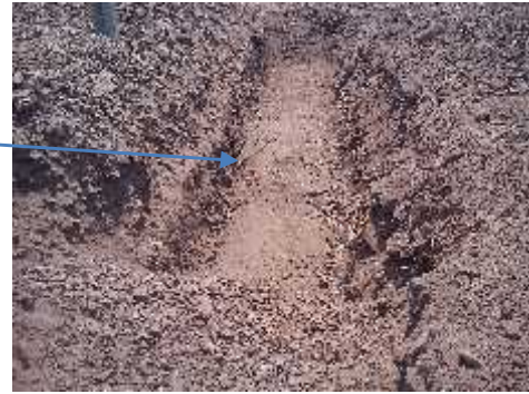
EXCAVACIÓN DE CEPAS PARA LA CONSTRUCCIÓN DE MURO DE MAMPOSTERÍA, EN ÁREA DE ALMACENAMIENTO. . AUTOR. EDUARDO SANCHEZ ZUÑIGA, AGOSTO DEL 2011
