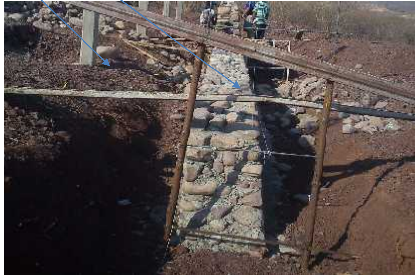
CONSTRUCCIÓN DE MURO DE MAMPOSTERÍA EN NAVE DE ALMACENAMIENTO, ADEMÁS DE LA CONSTRUCCIÓN DE ZAPATA AISLADA Y DADO PARA LA TECHUMBRE. AUTOR. EDUARDO SANCHEZ ZUÑIGA, AGOSTO DEL 2011
