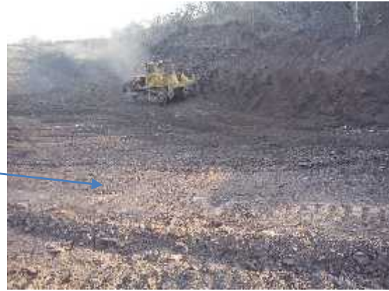
PROCEDIMIENTO CONSTRUCCIÓN DE LA CELDA EMPLEANDO UN TRACTOR D-7 CAT. AUTOR. EDUARDO SANCHEZ ZUÑIGA, ABRIL DEL 2011
