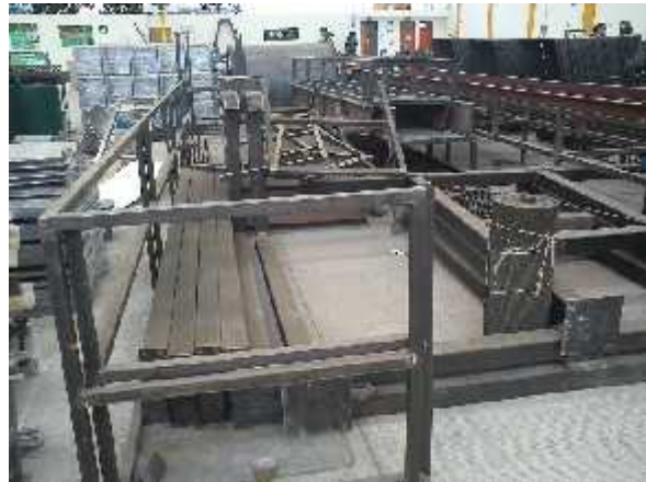
PROCESO DE CONSTRUCCIÓN DE LA PLANTA DE SEPARACIÓN EN LA CIUDAD DE URUAPAN MICHOACÁN. AUTOR EDUARDO SÁNCHEZ ZÚÑIGA. FECHA 13 DE MARZO DEL 2012
