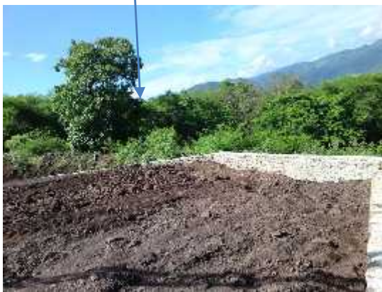
RELLENO Y COMPACTACIÓN EN ÁREA DE NAVE DE ALMACENAMIENTO AUTOR. EDUARDO SANCHEZ ZUÑIGA, AGOSTO DEL 2011
