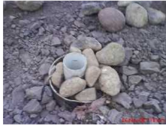
AUTOR: EDUARDO SÁNCHEZ ZÚÑIGA. FECHA 23 DE OCTUBRE DEL 2008, INSTALACIÓN DEL SISTEMA DE VENTEO EN TIRADERO CONTROLADO MUNICIPAL.
