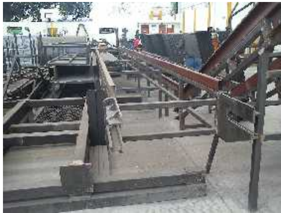
PROCESO DE CONSTRUCCIÓN DE PLANTA EN CIUDAD DE URUAPAN AUTOR: EDUARDO SÁNCHEZ ZÚÑIGA. FECHA 13 DE MARZO DEL 2012
