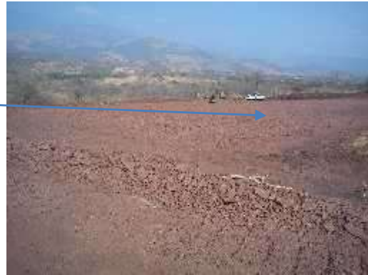
PROCEDIMIENTO DE CONSTRUCCIÓN DE PATIOS VISTA HACIA EL NORTE AUTOR. EDUARDO SANCHEZ ZUÑIGA, FEBRERO DEL 2011
